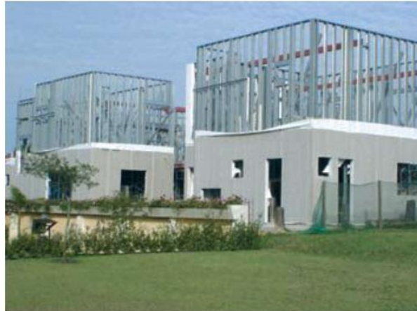
Figura 08: Utilização de placa cimentícia no LSF
