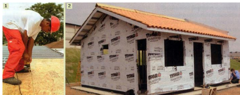
Figura 07: Residência em OSB impermeabilizada
