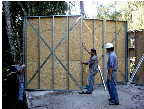
Figura 04: Contraventamento em X
