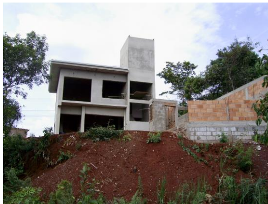
Figura 6 - Fachada fundos da edificação - Dez/2007
