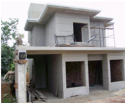
Figura 5 - Fachada frontal da edificação
