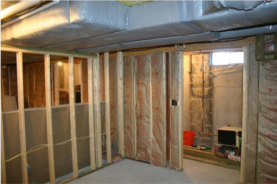
Figura 10-4. Parede termoacústica:Facilidade de execução .
