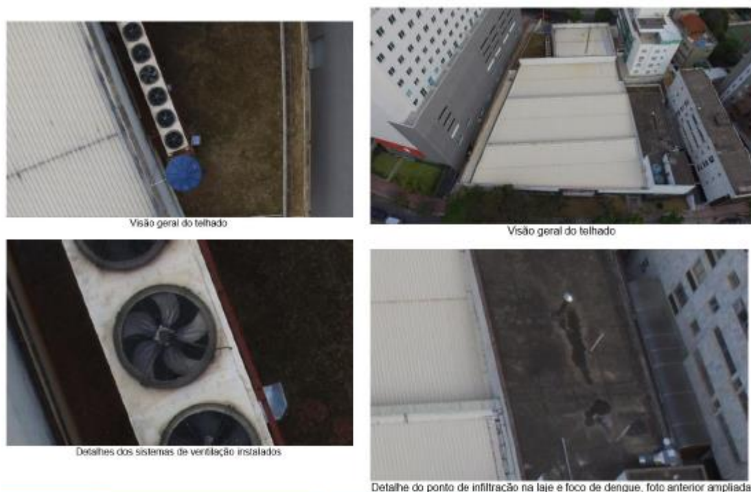
Figura 6: Inspeção Predial por Imagens
